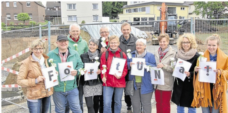
„FortUNa“ nennt sich die Gruppe, die das Mehrgenerationenprojekt an der Weberstraße finanziert und mit Leben füllen wird. Gestern erfolgte der erste Spatenstich.
