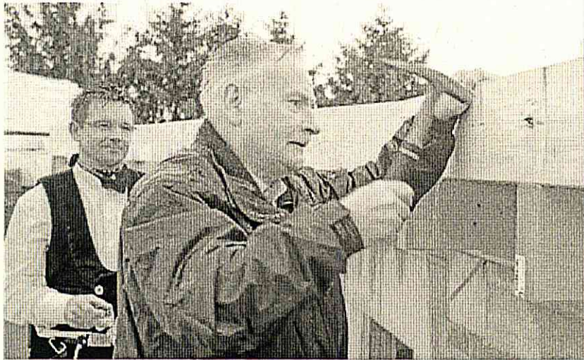
Als Investor Rolf Radimerski den symbolischen letzten Nagel im Neubau im Falkenhain eingeschlagen hatte, setzte sogar der Regen aus. Ein gutes Zeichen für das Mehrgenerationenprojekt. ■ Foto: Grzelak
